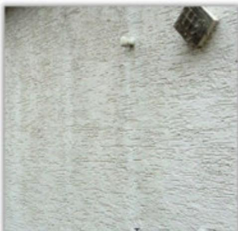
Die Aussenwände sind massiv mit Hohlblocksteinen gemauert und beidseitig verputzt. Der Anstrich wurde mehrfach überstrichen.
