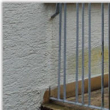
Zu den materialbedingten Wärmebrücken zählt das eingeputzte Geländer. Das ist eine punktförmige Wärmebrücke.
