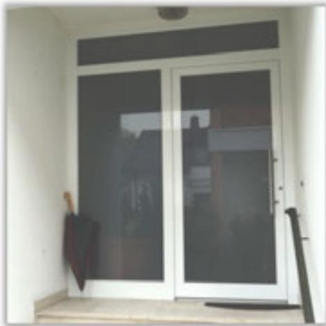
Die Haupteingangstür wurde 2008 erneuert, da es zu massiven Zugbelastungen infolge Undichtigkeiten an der damals Einfachverglaste Tür gekommen ist.
