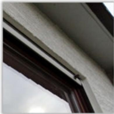
Die ungedämmten Rollladenkästen sind eine erhebliche Wärmebrücke, da auch deren innere Abdeckung nicht luftdicht ist.
