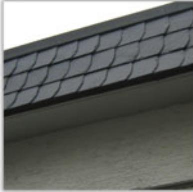
Auch die überstehende EG-Decke ist eine weitere Wärmebrücke. Kalte Außenluft kühlt den Beton stark ab.
