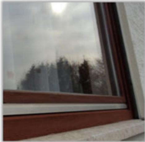
Beim Bau des Hauses hat man sich für Holzfenster mit einer Zweischeiben-Isolierverglasung entschieden. Diese haben einen Dreh-Kipp-Beschlag. Auf der Südseite ist eine große Schiebetür verbaut. Alle Fenster und Fenstertüren sind mit aussenseitigen, manuell betriebenen Rollläden ausgestattet. Die Rolllädenkästen über den Fenstern sind ungedämmt.
